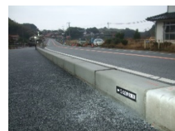
道路ブロック
