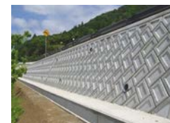
護岸ブロック
